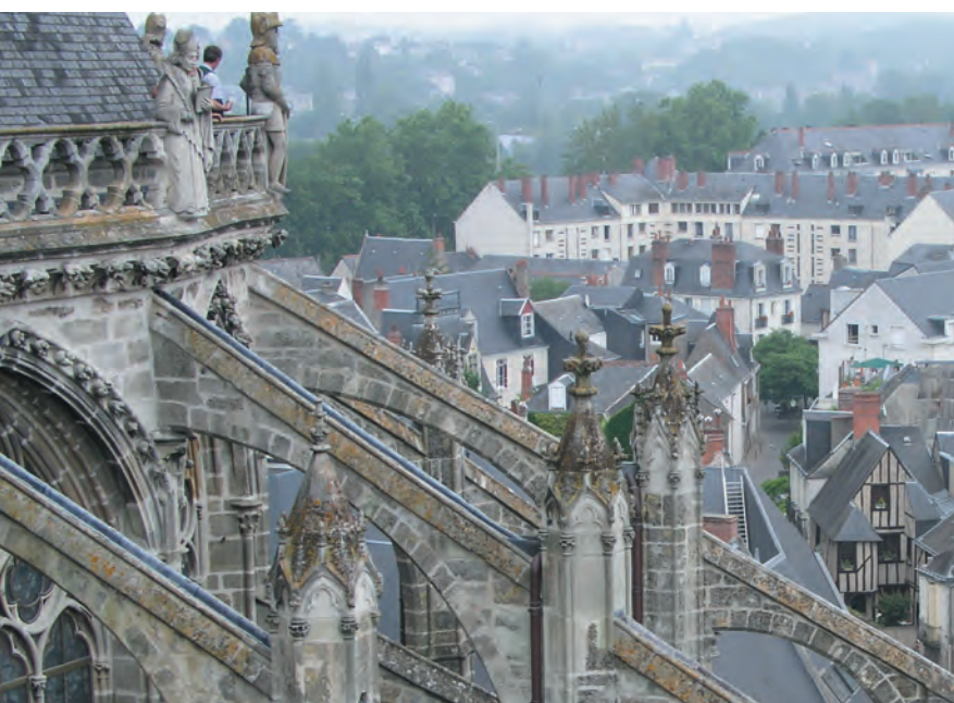
Fig. 17. Flying buttresses at Cathédrale Saint-Gatien, Tours.
